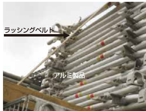
木製品やアルミ製品にはワイヤーではなくラッシングベルトを使用
