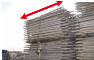
締め過ぎで建柱に反り発生
