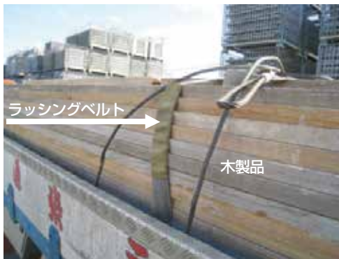
木製品やアルミ製品にはワイヤーではなくラッシングベルトを使用
